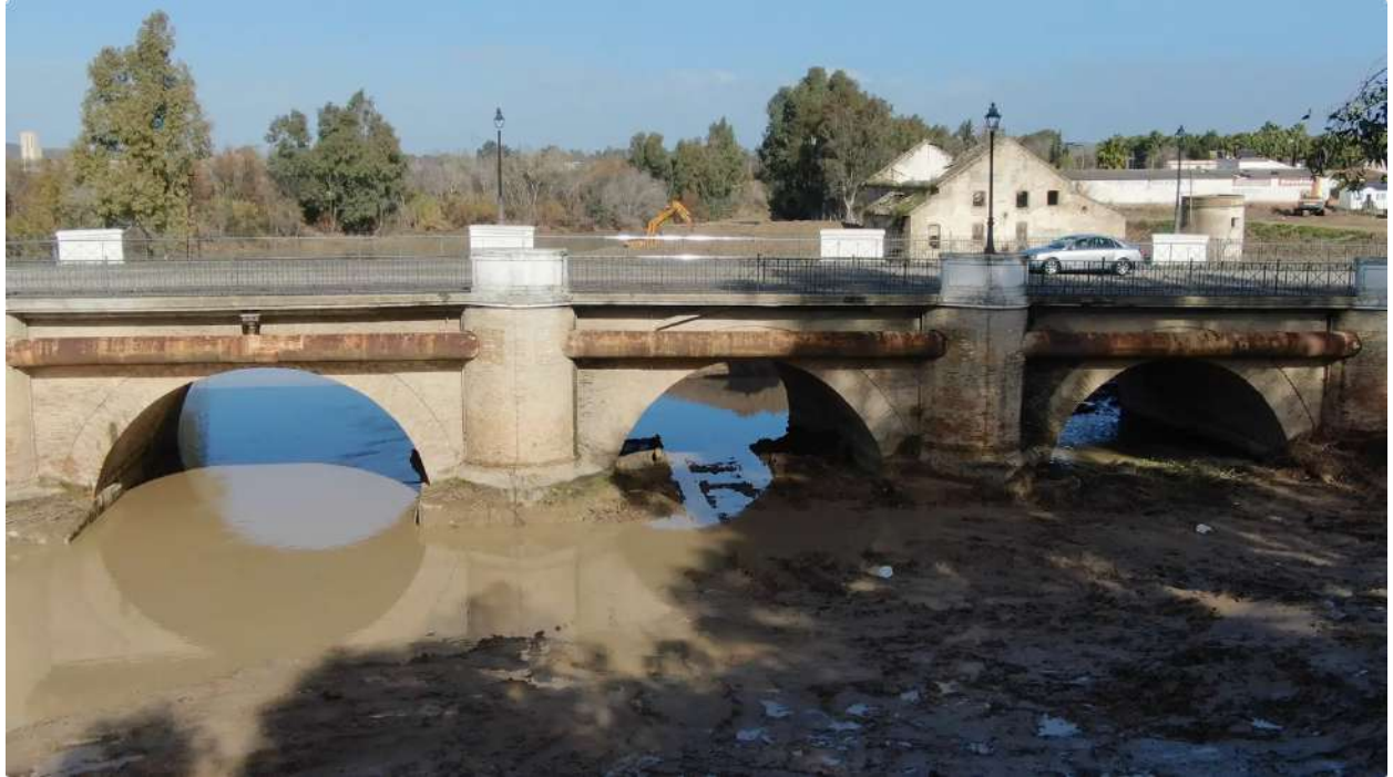
Foto 2. Ha comenzado la limpieza bajo los arcos cegados del Puente Romano
