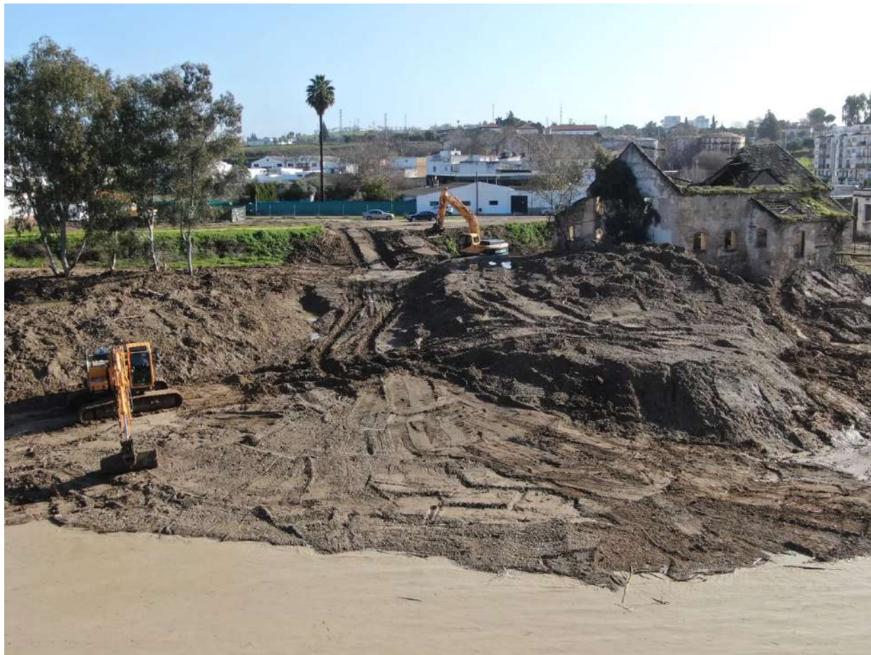
Foto 1. Los camiones no pueden acceder a la playa fluvial por el barro. Las excavadoras hacen acopios intermedios para que la arena pierda humedad y poder llevarla al punto de carga (al fondo en la imagen)
