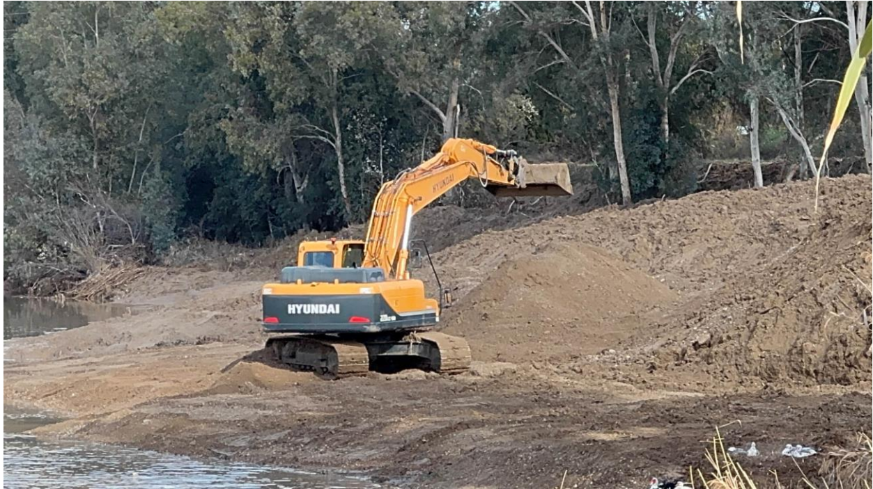
Maquinaria trabajando en la limpieza de cauce aguas abajo del azud
