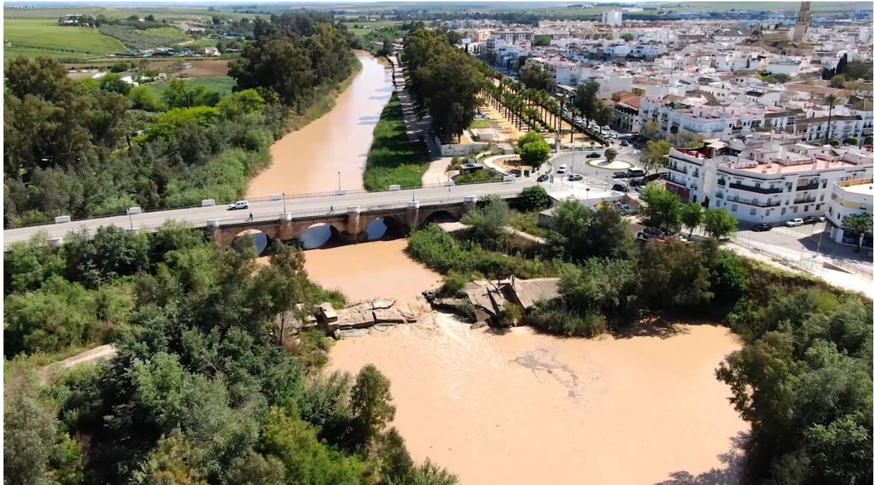
En la imagen, el azud con su tramo central derruido y la mitad de ojos del Puente Romano cegados
